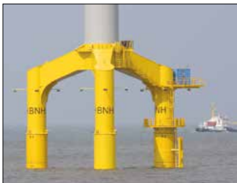
▲ Livellamento di turbine eoliche offshore: Il sistema di sollevamento sincrono di Enerpac ha fornito la soluzione per il livellamento delle basi ad incrocio 80 turbine eoliche.
